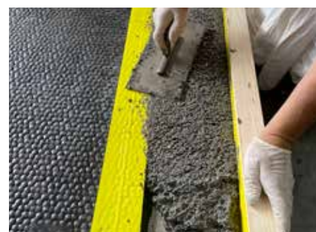
Remplir les bords avec des granulés de caoutchouc.
