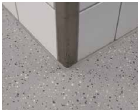
Urin- und wasserdichte Fugen
