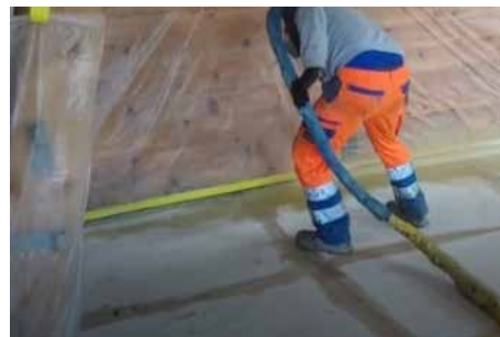
LES REVÊTEMENTS ELASTIKSPRAY SONT APPLIQUÉS RAPIDEMENT ET SÈCHENT EN QUELQUES SECONDES.
